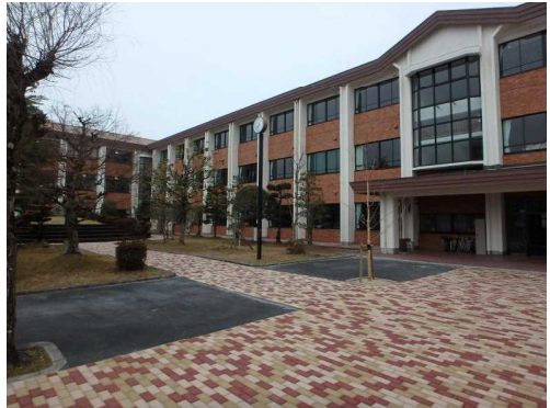
令和の大規模改修完成 令和3年2月
