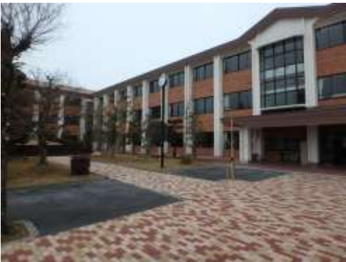
令和の大規模改修完成 令和3年2月
